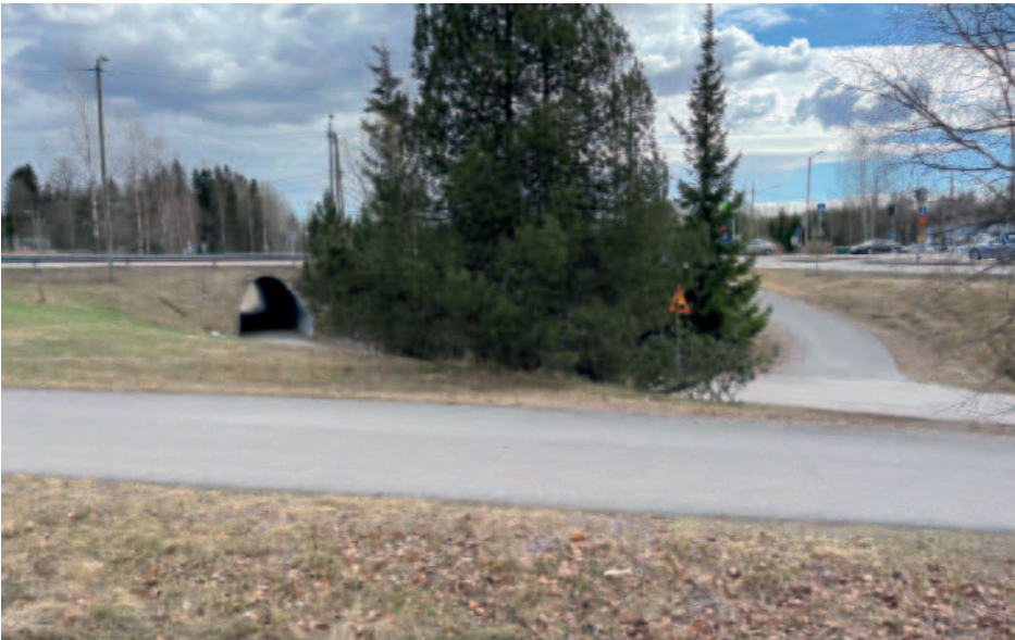
115. Eteläisempi ”uraputki”-alikulku on ympäristöltään avoimempi, mutta etenkin väylien liittymäkohtien väljyyteen pitää kiinnittää huomiota.
