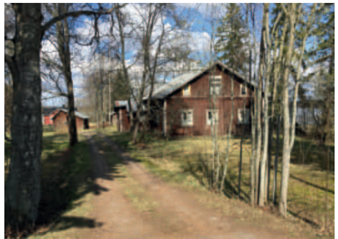
17. Saarelan pihapiiri on autoitumassa. Kohde olisi upea ja upealla paikalla, jos joku haluaisi sen pelastaa.
