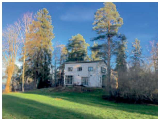
130. Tiilikanojan päärakennus etelästä.
