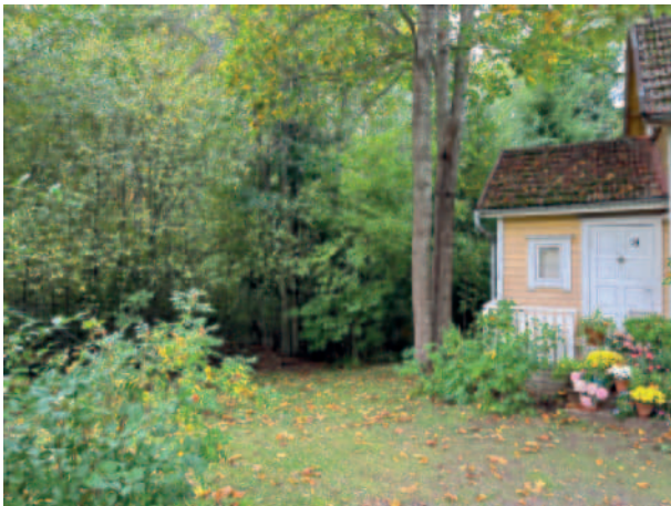
104. Aattolan eteläpuoleinen piha on hyvin varjoisa. Nurmikko on sammaleinen, ja myös talon eteläosan betonitiilikatto on sammalen peittämä. Aivan eteläpäädyn vieressä kasvava suuri, monihaaraainen vaahtera olisi syytä poistaa, jotta rakennuksen hoito ja säilyttäminen olisi helpompaa.
